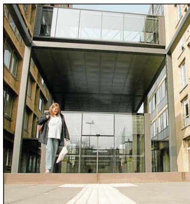
2010 beseitigt: das Podest, das anfangs zum Bild des neu gestalteten Rathauseingangs gehörte. Archivbild: Dinkels
